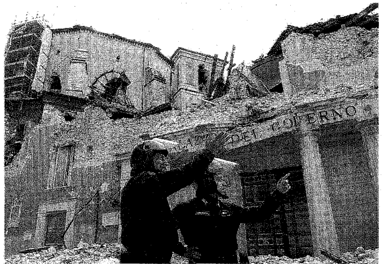
Terremoto La prefettura dell'Aquila distrutta dal sisma nel 2009
